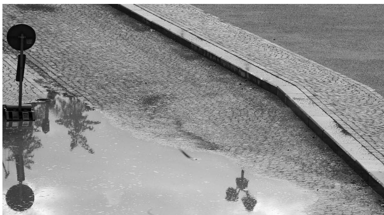
Heraanleg Zoutwerf: niet echt superieure engineering....
