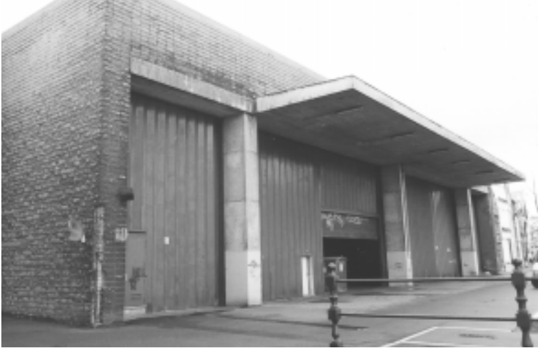
De parking van Lamot aan de Haverwerf
